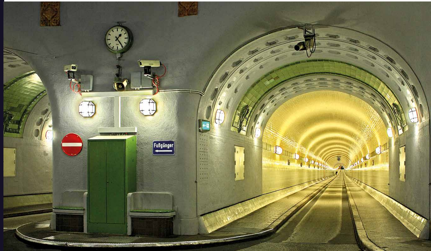
Wandleuchten als Einzelfertigung, alter Elbtunnel, Hamburg
